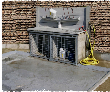
Aire étanche avec bordures et capacité de rétention suffisante
