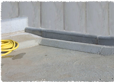
Aire étanche avec bordures et capacité de rétention suffisante
